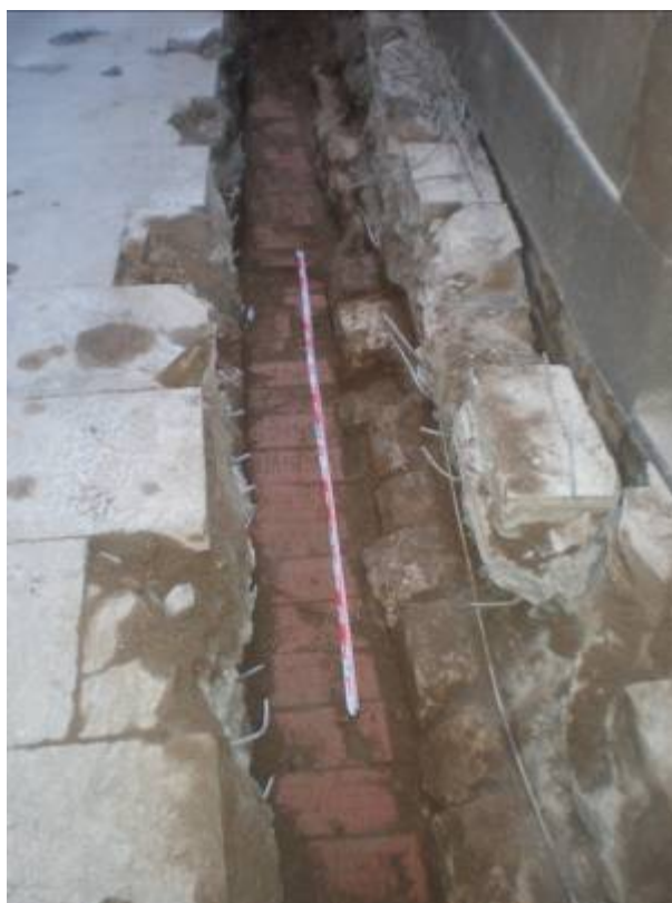
Foto 20: Vista general UE 5 i rasa UE 3 amb servei UE 4
