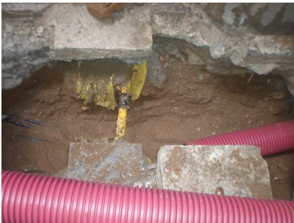
Foto 4: Zona de serveis actius a l'alçada del núm. 1-3
