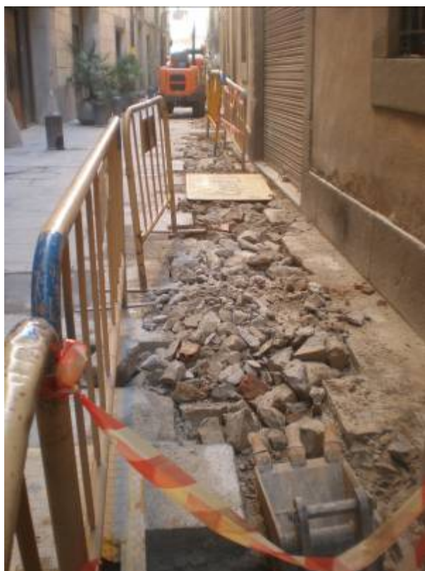
Foto 6: Inicial amb demolició del paviment en el tram de la finca 1-3. Nord
