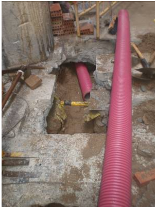
Foto 3: Zona de serveis actius a l'alçada del núm. 1-3
