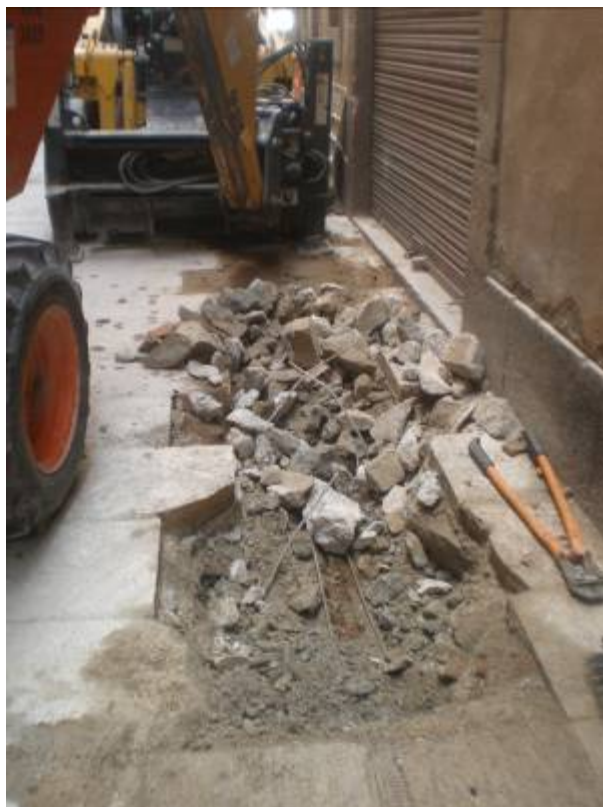
Foto 9: Tasques d'excavació mecànica en el tram de la finca 1-3. Nord
