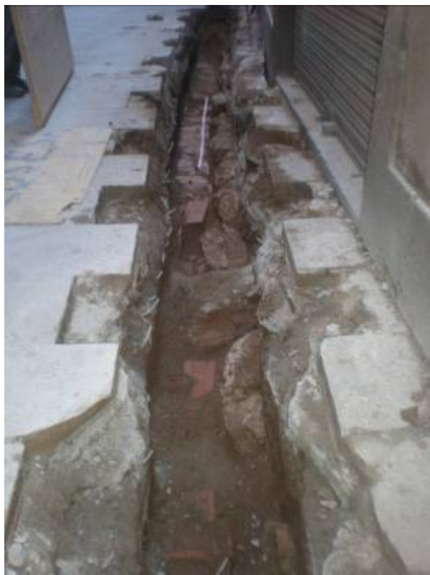
Foto 19: Vista general UE 5 i rasa UE 3
