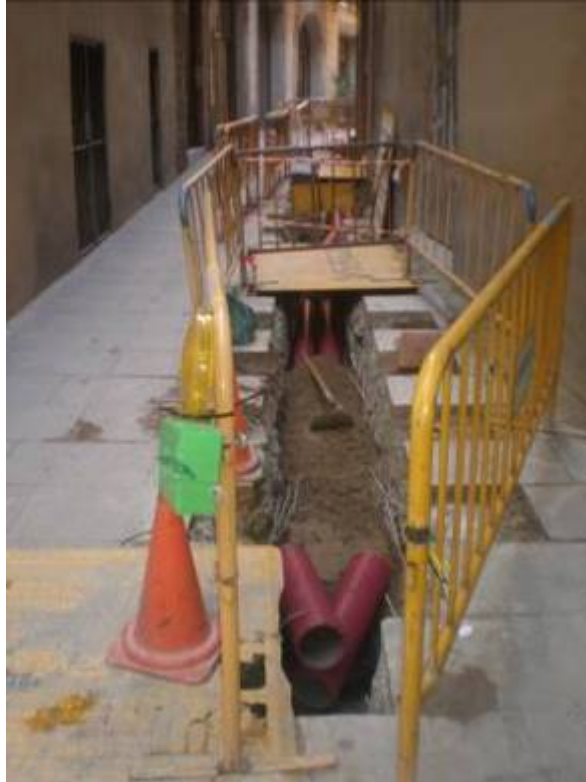
Foto 1: Primer tram de rasa efectuat al carrer Palma de Sant Just. Nord
