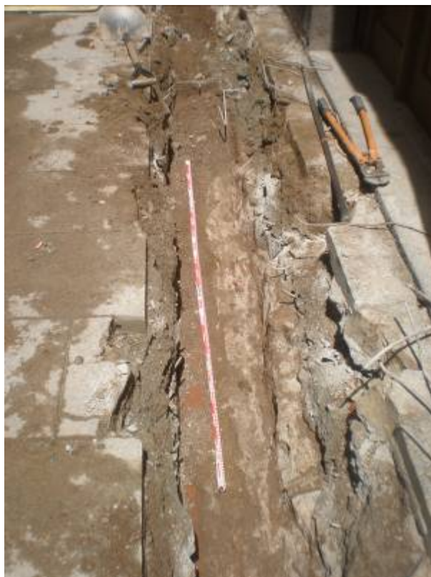
Foto 32: UE 5 en el tram final de la rasa
