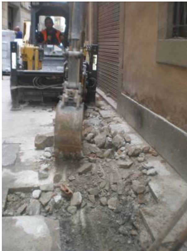
Foto 8: Inicial de tasques d'excavació mecànica en el tram de la finca 1-3. Nord
