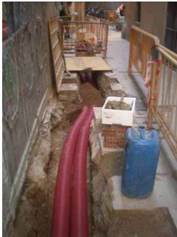
Foto 2: Primer tram de rasa efectuat al carrer Palma de Sant Just. Sud
