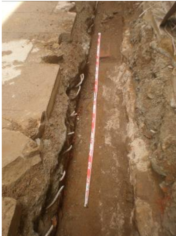
Foto 31: UE 5 en el tram final de la rasa
