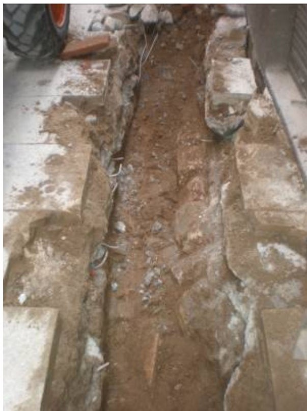
Foto 13: Localització de la banqueta de cimentació de l'edifici UE 5
