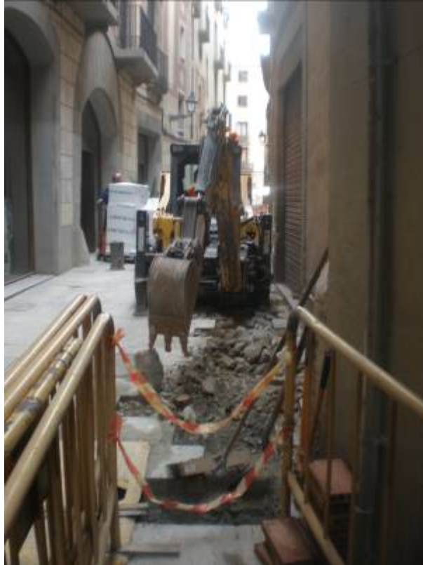
Foto 7: Inicial amb demolició del paviment UE 1 en el tram de la finca 1-3. Nord
