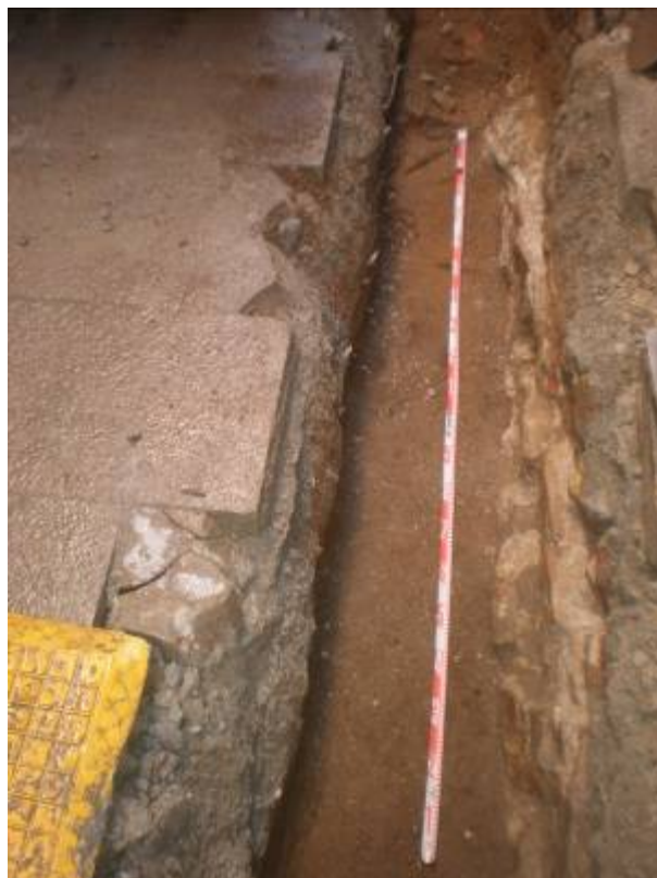
Foto 23: Continuació de la rasa en direcció N. Detall UE 5 amb estrat UE 2
