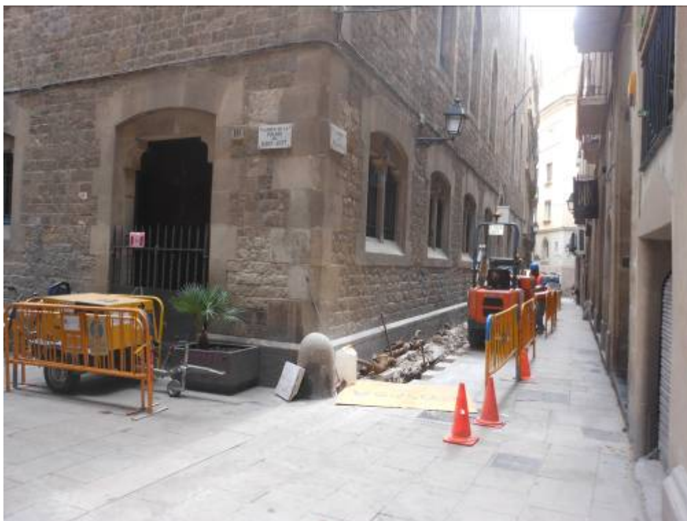
Foto 39: Inici dels treballs
