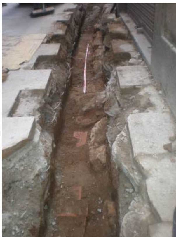
Foto 14: Banqueta de cimentació de l'edifici UE 5 i servei UE 4
