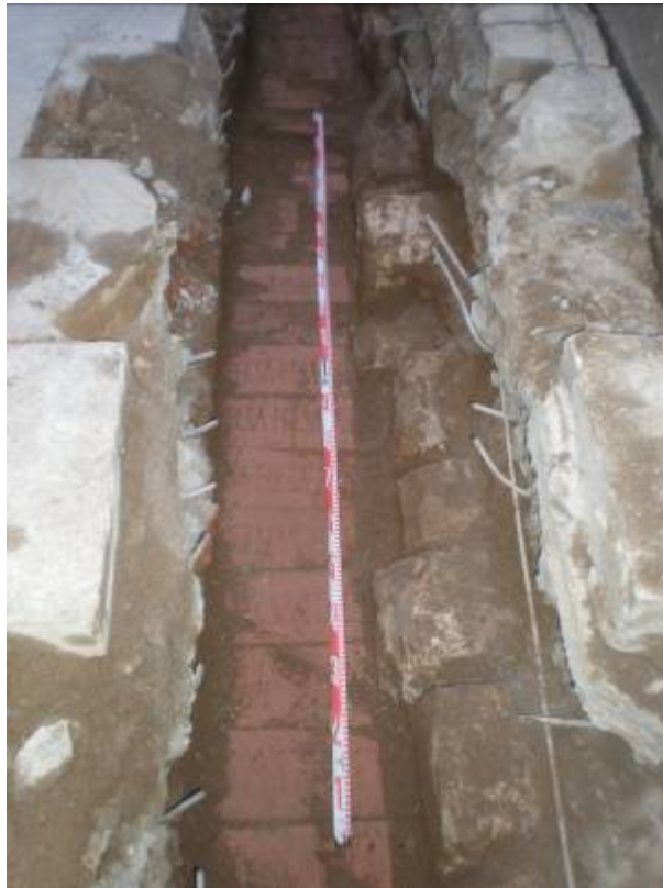
Foto 21: Detall UE 5 i rasa UE 3 amb servei UE 4
