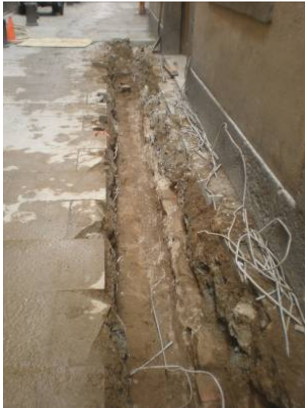
Foto 33: UE 5 en el tram final de la rasa
