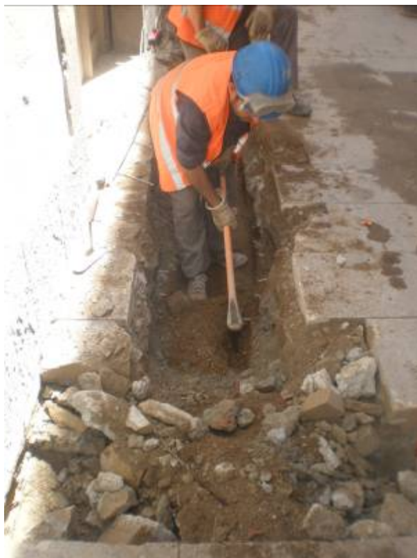
Foto 5: Tasques d'excavació manual en un punt amb serveis actius
